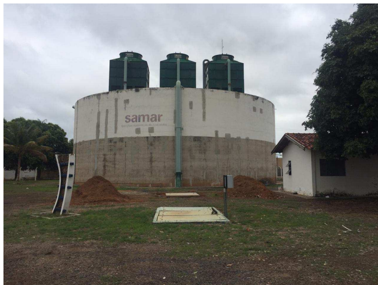
Figura 23 – Reservatório do Jussara.
