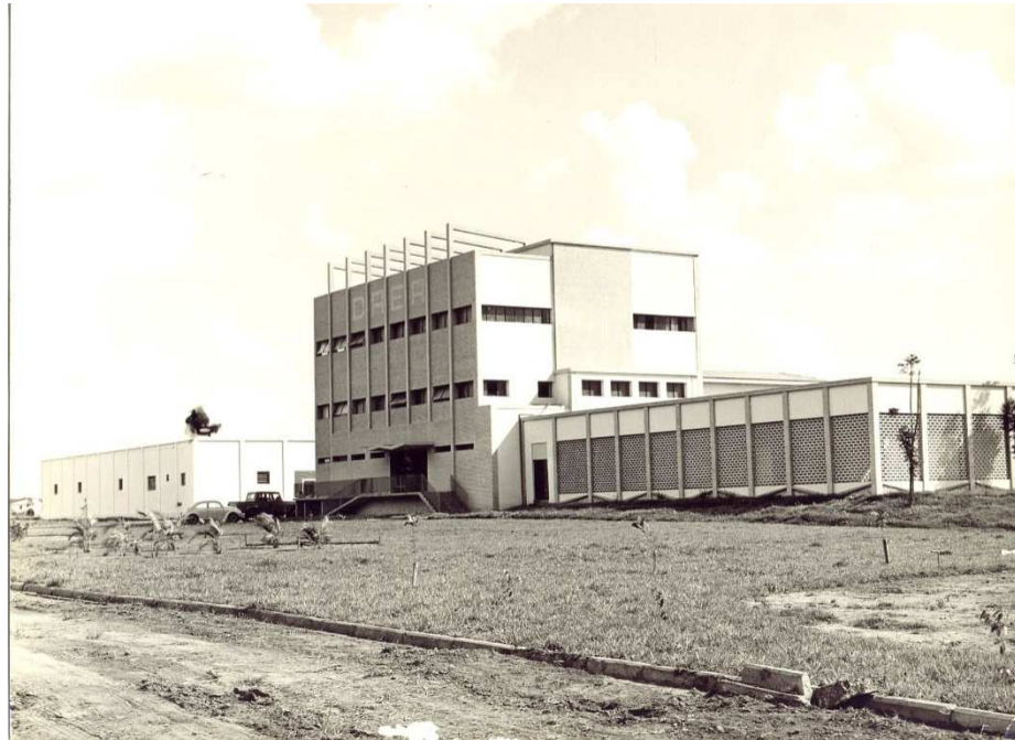
Figura 20 – Estação de Tratamento de Água
